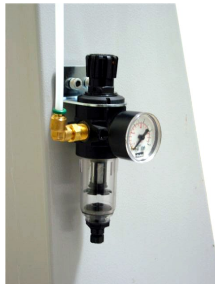
Figura 1.31 - Detalhe do Filtro de Ar
