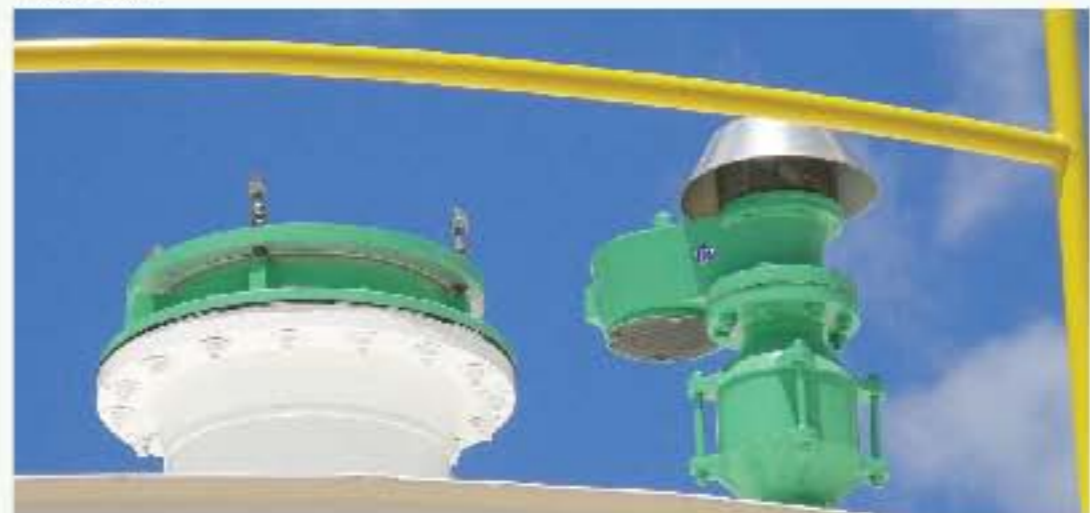
Arrestador aislando fuego del exterior al interior del tanque.
